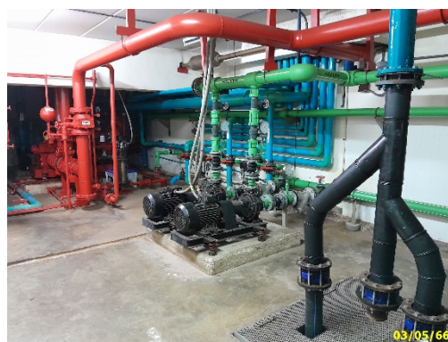
เครื่องสูบน้ำใช้ และน้ำดับเพลิง รวมทั้งถังเก็บน้ำชั้นใต้ดิน
