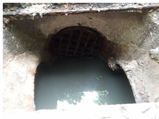
ตะแกรงดักขยะในท่อระบายน้ำ
